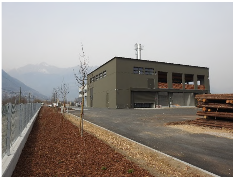
centrale di Merano Sud
