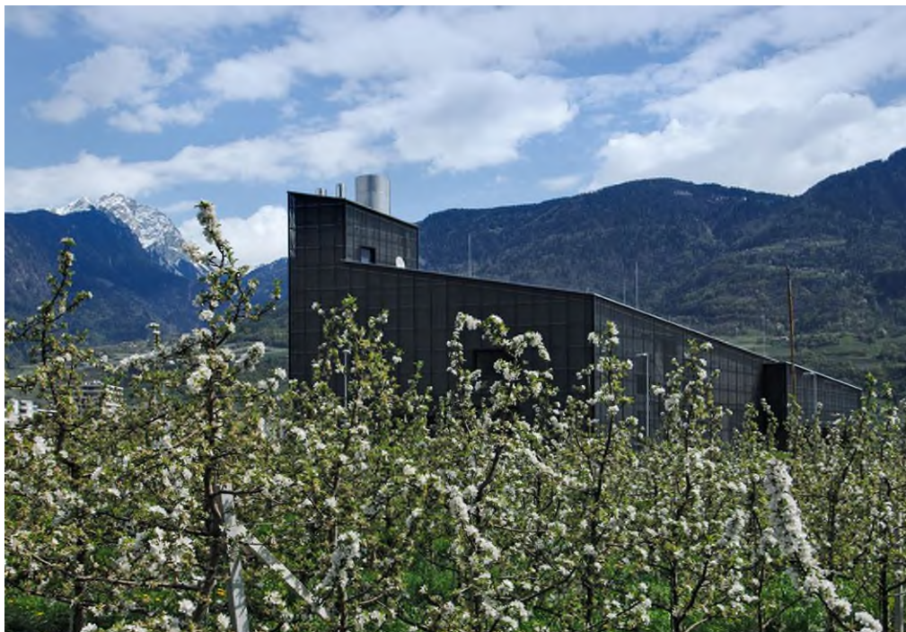
Centrale di Maia Bassa
