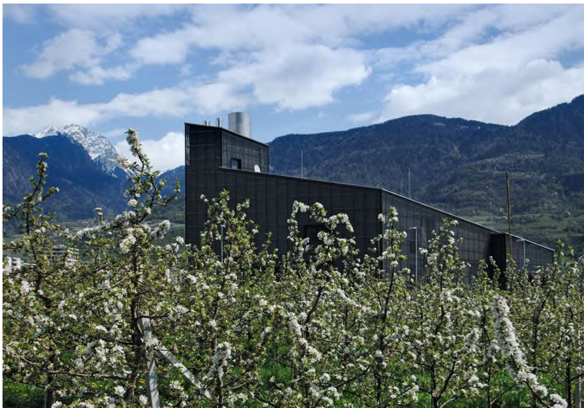
Centrale di Maia Bassa
