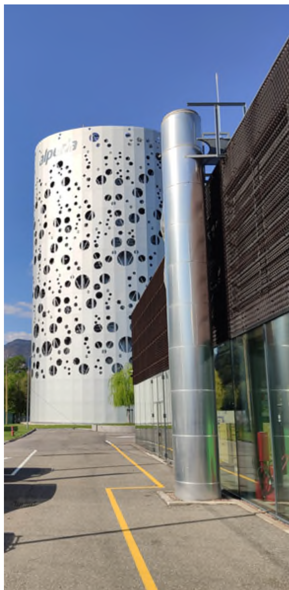
Centrale di Bolzano
