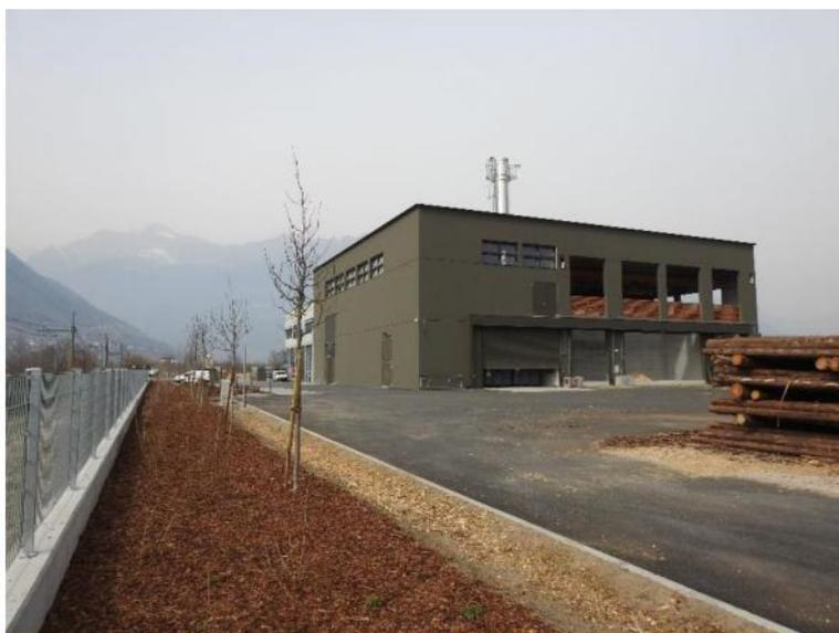
Il fulcro della nuova centrale è la caldaia a biomassa, finalizzata a diminuire le emissioni di CO<sub>2</sub> della rete di teleriscaldamento. La biomassa è finora cippato di legna naturale come nelle altre centrali ma a regime l'impianto è in grado di gestire anche un 20% di biomassa proveniente dal verde urbano. L'impianto può essere schematizzato come di seguito:
