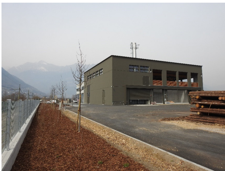
centrale di Merano Sud
