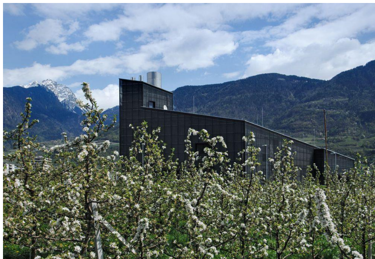
Centrale di Maia Bassa
