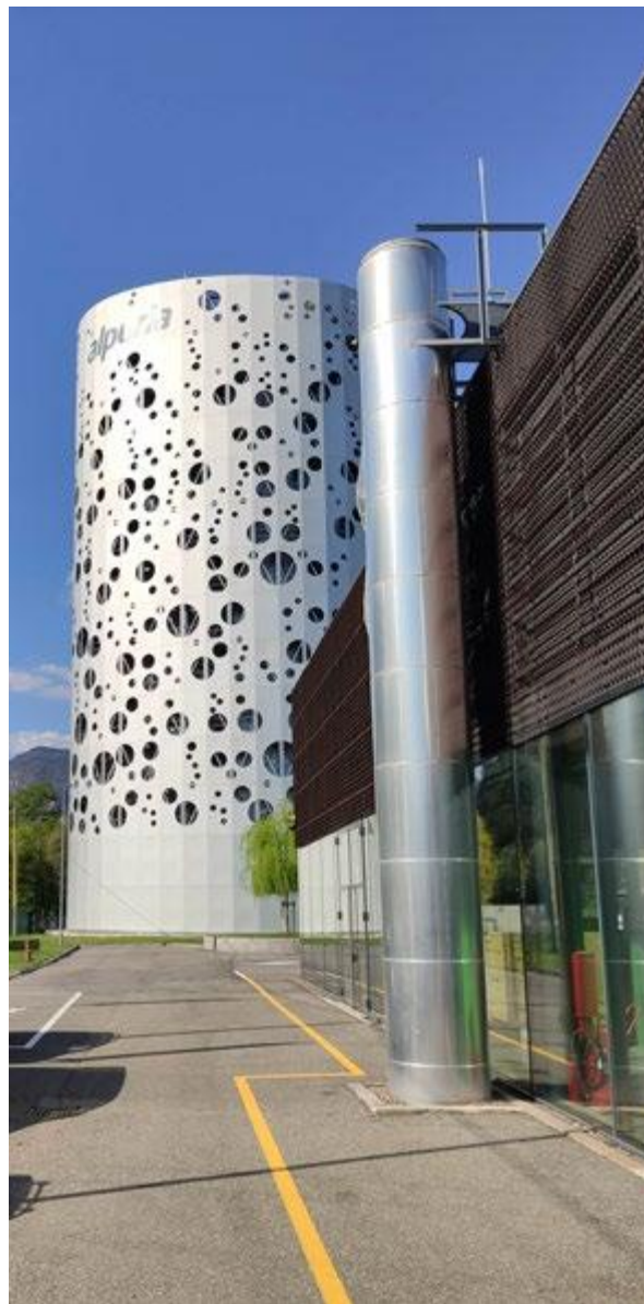
Centrale di Bolzano
