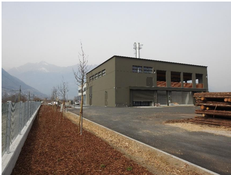
Centrale di Merano Sud
