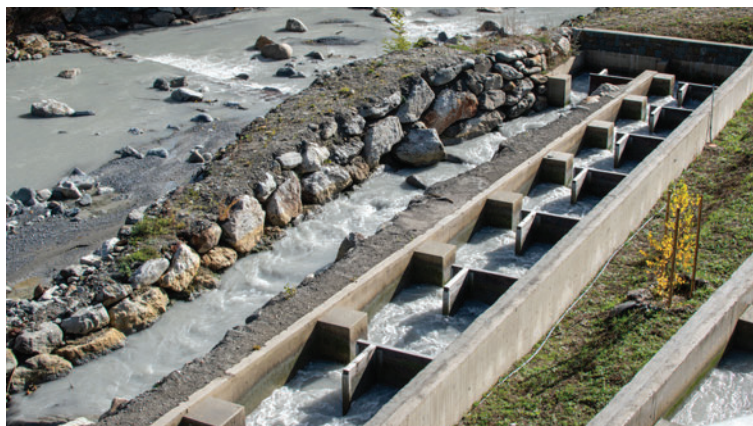
Scala di risalita pesci presso la centrale di Lasa (Val Venosta)
