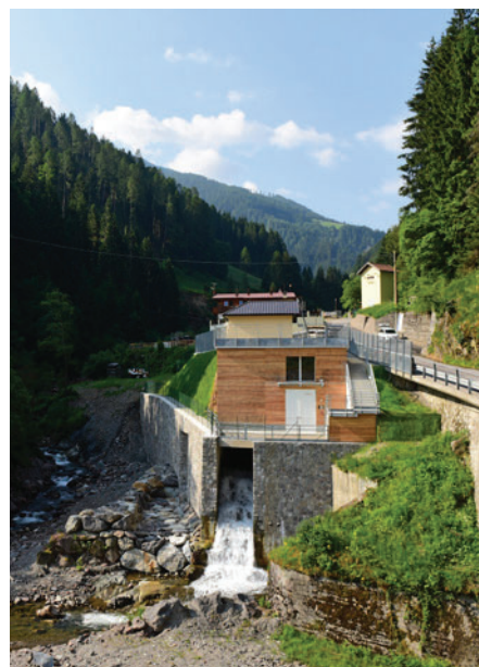
Centrale DMV di Alborelo (Val d'Ultimo)
