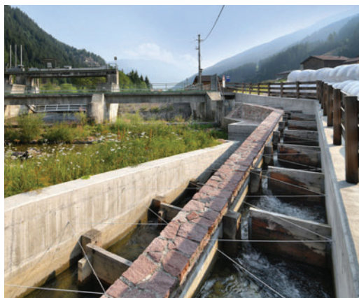
Scala di risalita pesci della centrale di Sarentino
