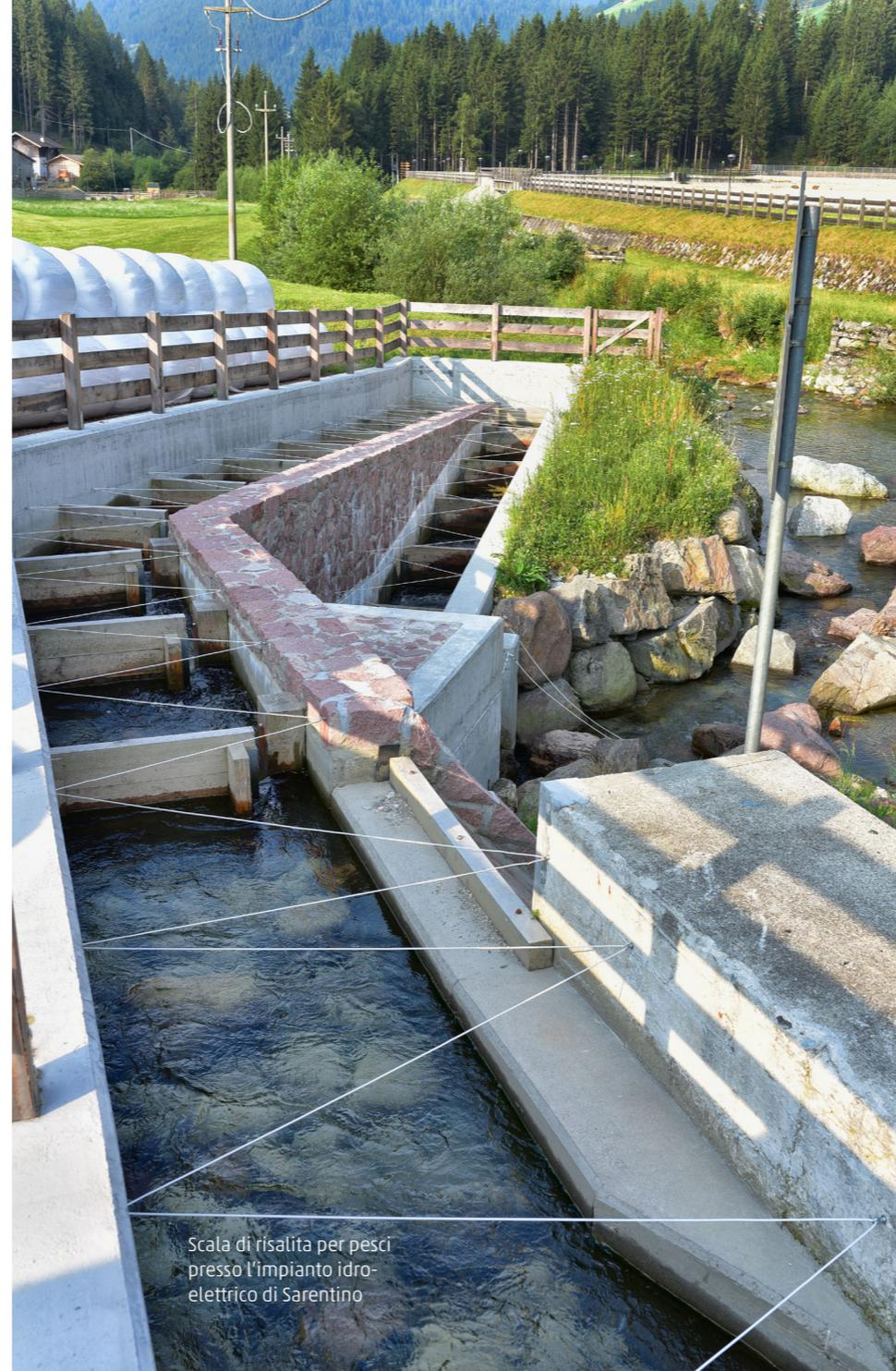
Scala di risalita per pesci presso l'impianto idroelettrico di Sarentino
