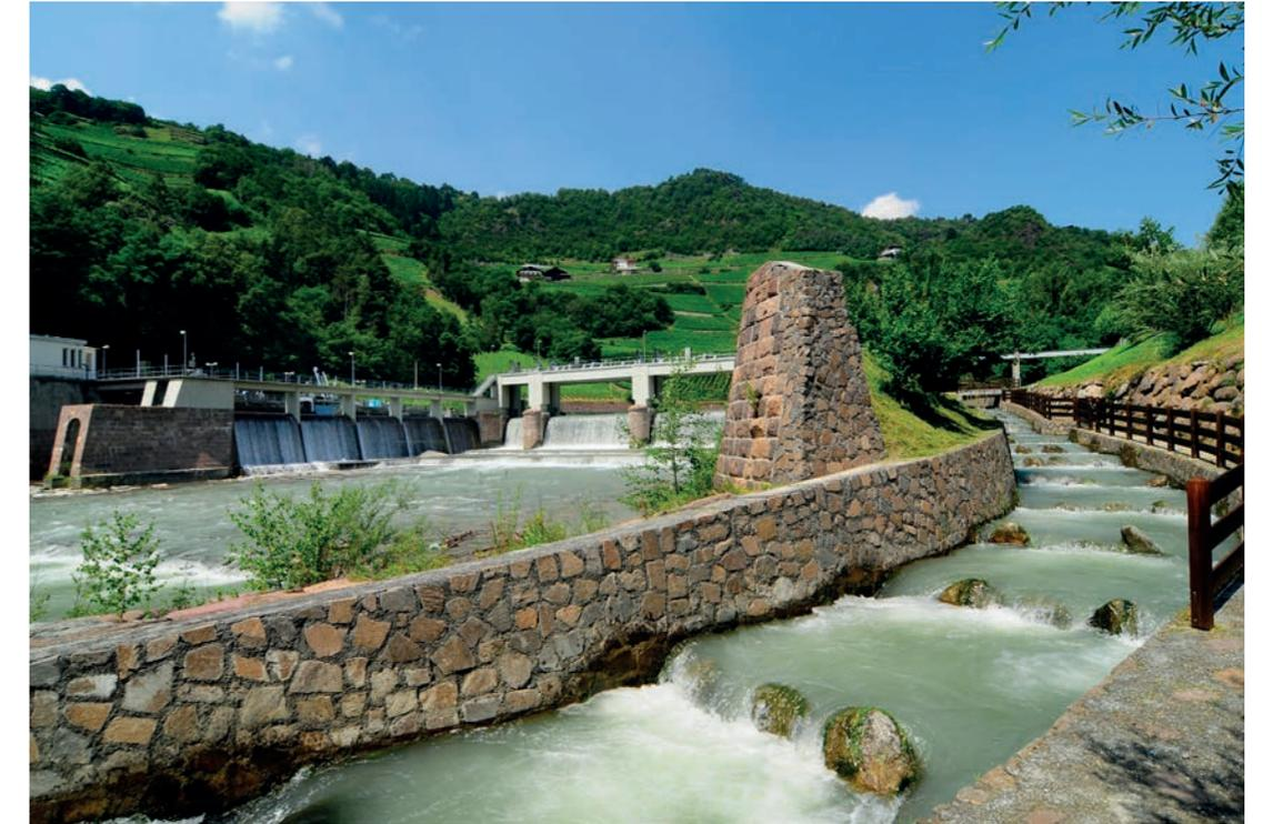
**Hochwassers talabwärts fließt** (Schichtung) zu regulieren, um so die maximale Wassermenge und folglich die zerstörerische Kraft des Wassers zu verringern. Dadurch wird der Bevölkerung **eine höhere Sicherheit gewährleistet** und die mögliche Auswirkungen auf das Ökosystem begrenzt. Weitere Informationen finden Sie im Kapitel "Asset Integrity".
