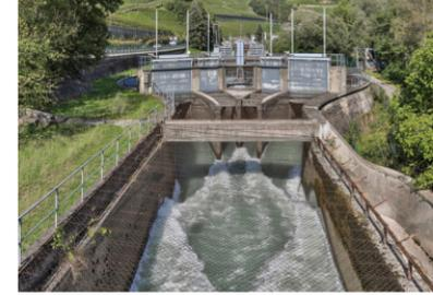
Le acque dell'Isarco vengono sbarrate da una traversa all'altezza di Funes e convogliate in una galleria di derivazione lunga 6.750 m. In seguito, l'acqua raggiunge una camera di carico. Dopo aver superato le paratoie interne attraversa le condotte forzate con un salto di circa 60 m, raggiungendo l'imponente centrale in caverna. All'interno di
