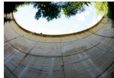
La **diga a cupola** alta 51 m, situata nel territorio comunale di Valdaora, forma un serbatoio artificiale della capacità di 4.800.000 m<sup>3</sup>, con quota massima di regolazione di 1.055 m s.l.m.
