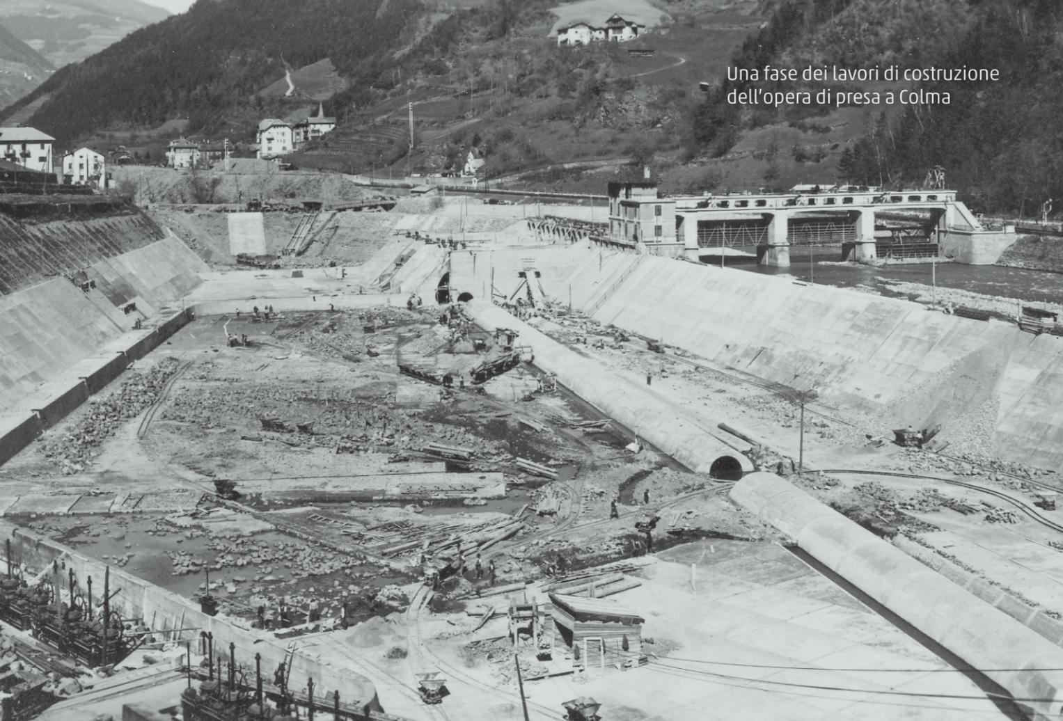
Una fase dei lavori di costruzione dell'opera di presa a Colma
