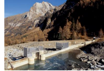
Nell'arco dell'anno nel bacino passano ca. 75 milioni di m<sup>3</sup> di acqua, in gran parte derivanti dallo scioglimento del ghiaccio del monte Cevedale. Dal bacino l'acqua viene immessa in una galleria di ca. 11 km fino al pozzo piezometrico posto sopra la località di Lasa. A 2,5 km dal pozzo piezometrico si immette in galleria il rio Lasa. A valle del pozzo piezo-
