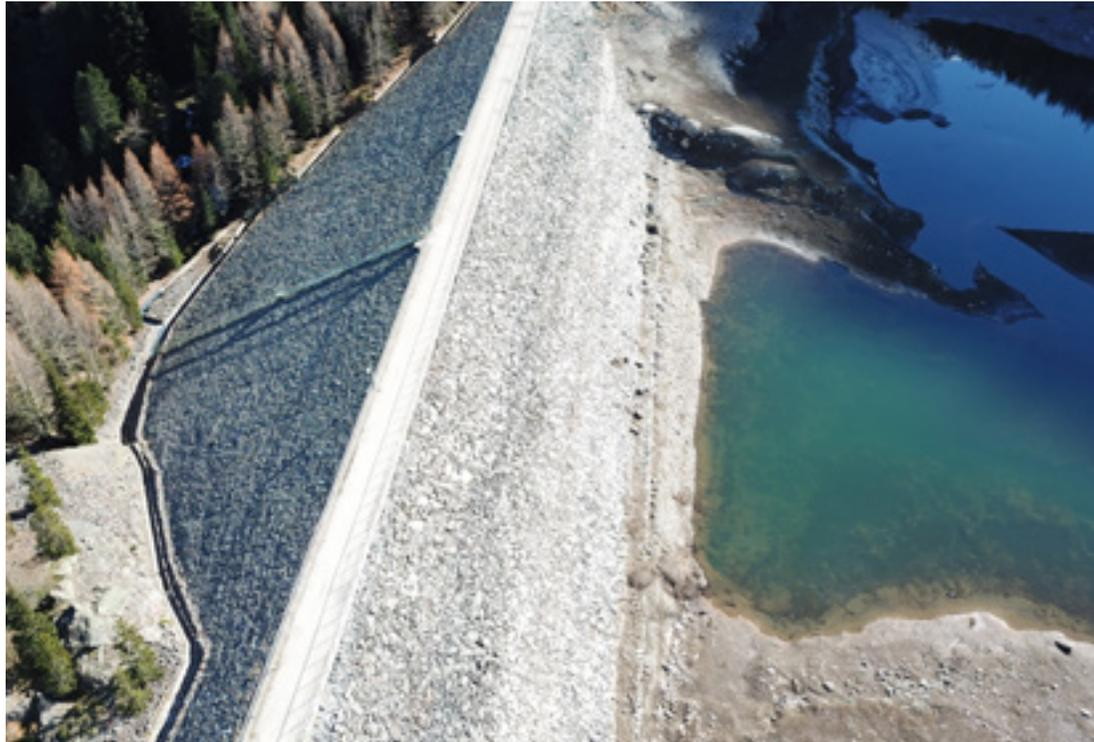
Dank des Einsatzes von Drohnen ist es möglich, auch die schwer zugänglichen Teile der Anlagen, wie Druckrohrleitungen oder Staumauern, effizient zu kontrollieren und zu überwachen. Im Foto die Staumauer Weißbrunn.
