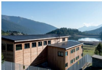
Über einen Stollen und eine Druckleitung wird das Wasser vom Grünsee in das Kraftwerk geleitet, das kürzlich renoviert und mit Holz verkleidet wurde, um es besser in die Umgebung einzubetten. Das Wasser aktiviert eine Pelton-Turbine und fließt dann in den gleichnamigen See, um die nächste Stufe des komplexen Wasserkraftsystems des Ultentals zu versorgen.
