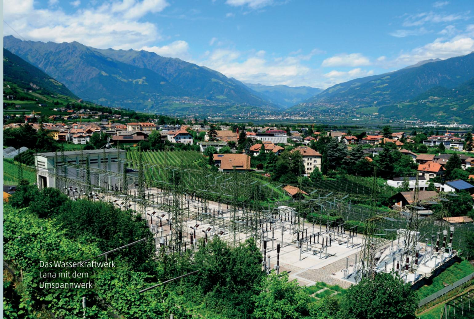
Mit einer installierten Leistung von 132 MW deckt das Wasserkraftwerk Lana den Strombedarf von rund 40.000 Familien. Das abgearbeitete Wasser wird in die Falschauer zurückgeleitet, nachdem es eine Gesamtfallhöhe von 2.200 m überwunden hat. Die Wasserkraftwerke Weißbrunn, St. Walburg, Kuppelwies, St. Pankraz, das Restwasserkraftwerk und das Wasserkraftwerk Lana werden von Alperia Greenpower, einer Tochtergesellschaft von Alperia, betrieben und von der Fernleitzentrale in Kardaun ferngesteuert.
