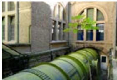
Vom Wasserschloss wird die Fallhöhe von 130 m bis zur Talsohle genutzt: Das Wasser stürzt über eine unterirdische Druckrohrleitung direkt in die Turbinen im darunterliegenden Kraftwerk. Die drei Maschinengruppen des Kraftwerks haben eine Gesamtleistung von fast 44 MW, wodurch der Strombedarf von mehr als 45.000 Familien gedeckt werden
