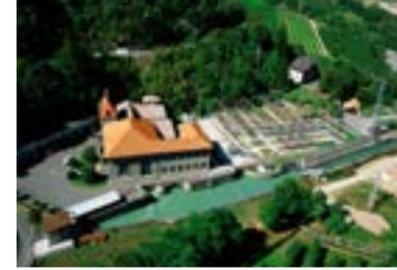
Das an der Töll gefasste Wasser wird durch einen 500 m langen Freispiegelstollen durch den Felsen in die unterirdische Wasserkammer geleitet. Von dort gelangt es über zwei Druckrohrleitungen zu den 4 Francis-Turbinen im Kraftwerk. Die Anlage nutzt die ersten 70 m Gefälle von 200 m Höhenunterschied zwischen Töll und dem Meraner
